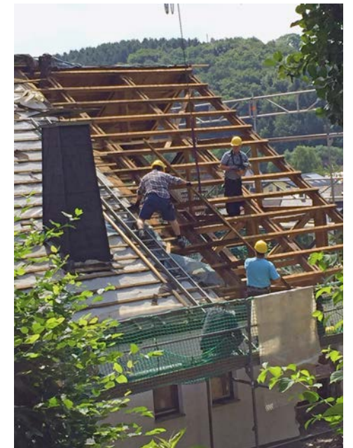
Abb. 03 Die Versöhnungskirche wird Stück für Stück abgebaut
