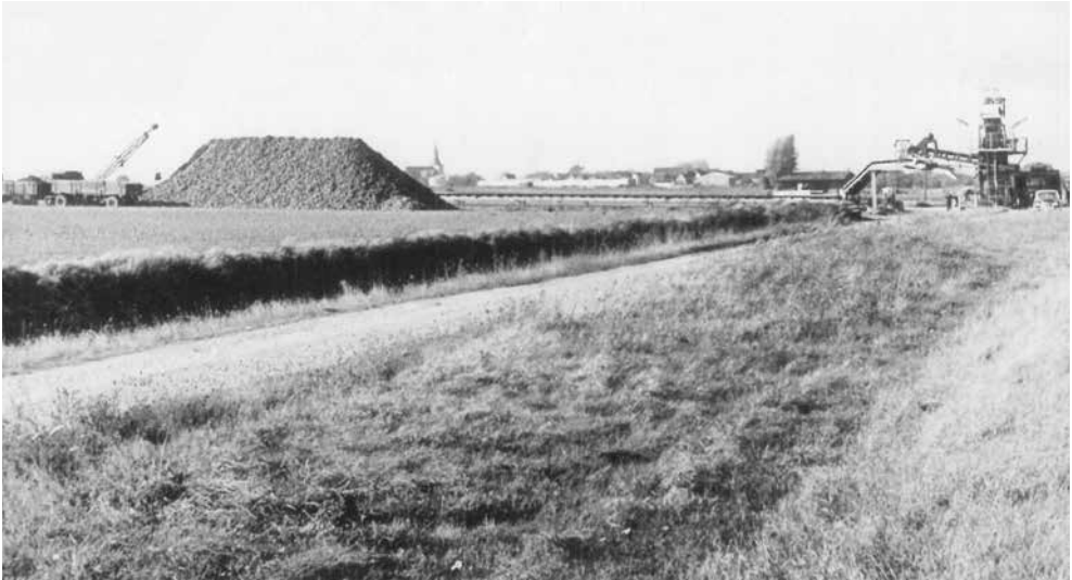
Rübenentladestelle der Firma Pfeiffer & Langen an der Friesheimer Str. um 1970.
