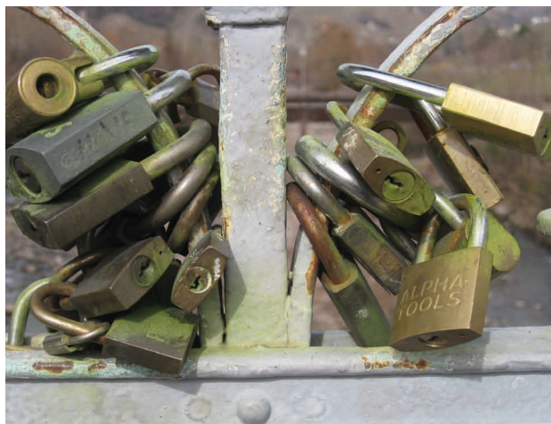
„Spindschlösser“ auf der Talferbrücke in Bozen.
